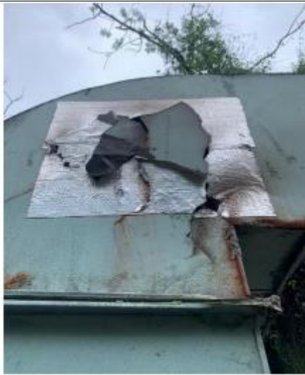
Peça: Coifa do exaustor Avaria: Rasgado
