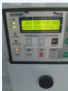
VOLTAR O GRUPO GERADOR PARA AUTOMATICO Testes 64
